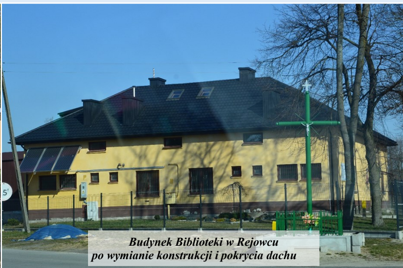
Budynek Biblioteki w Rejowcu przed modernizacją
